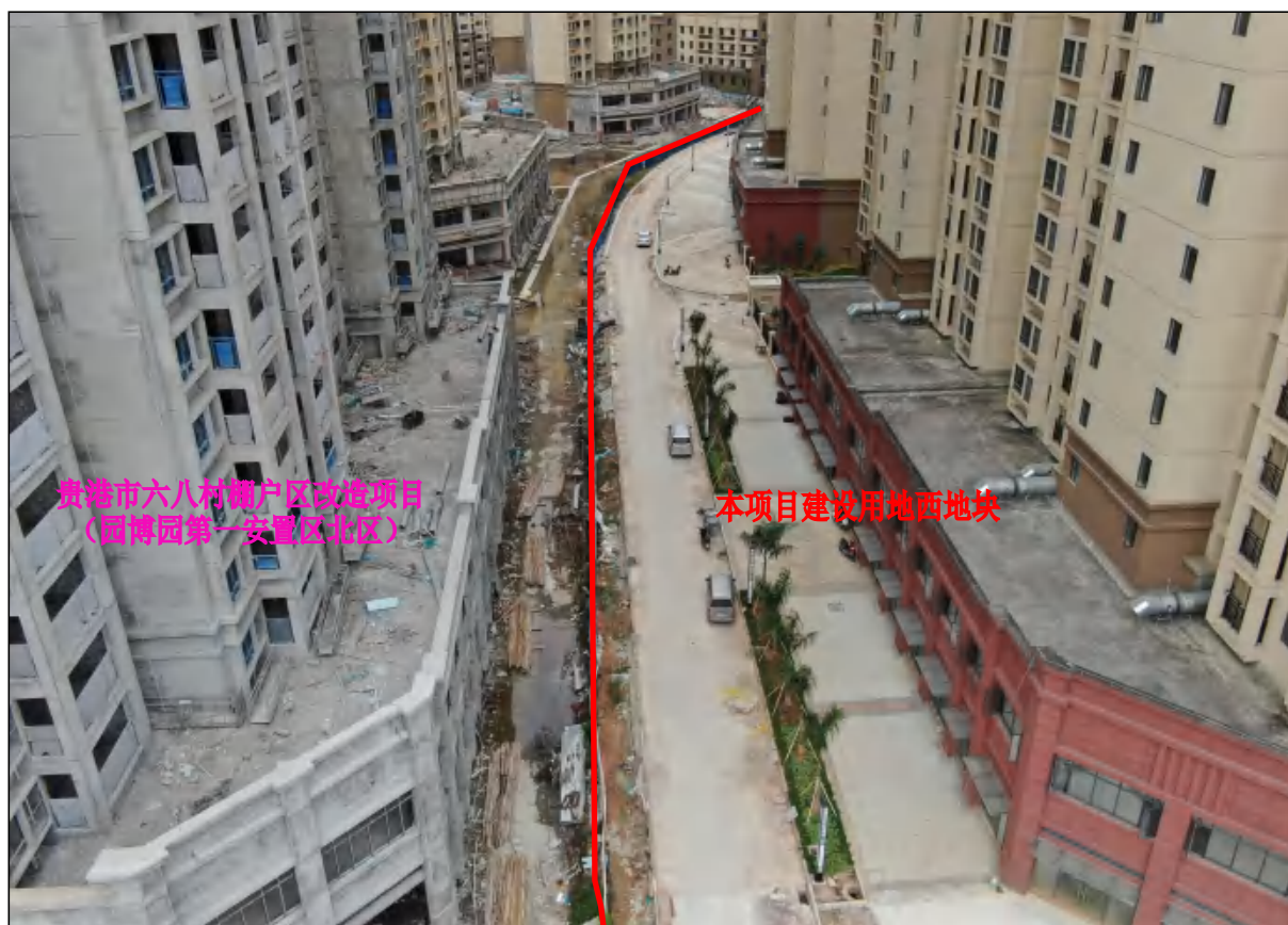
项目用地西地块东北面与北区交界处现状，现状已完成硬化铺砖，正在进行排水、道路等建设
