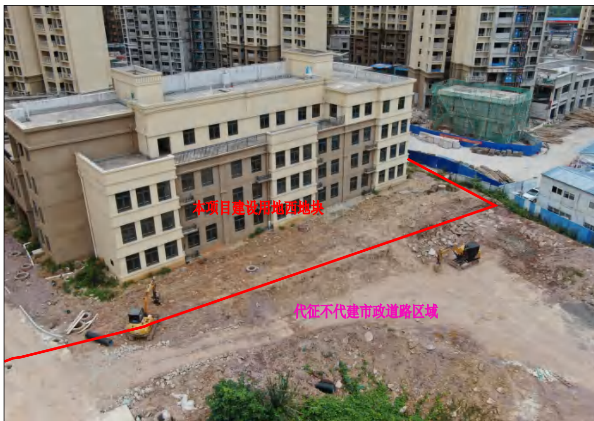
项目用地西地块东北角用地现状，现状正在进行硬化铺装工作
