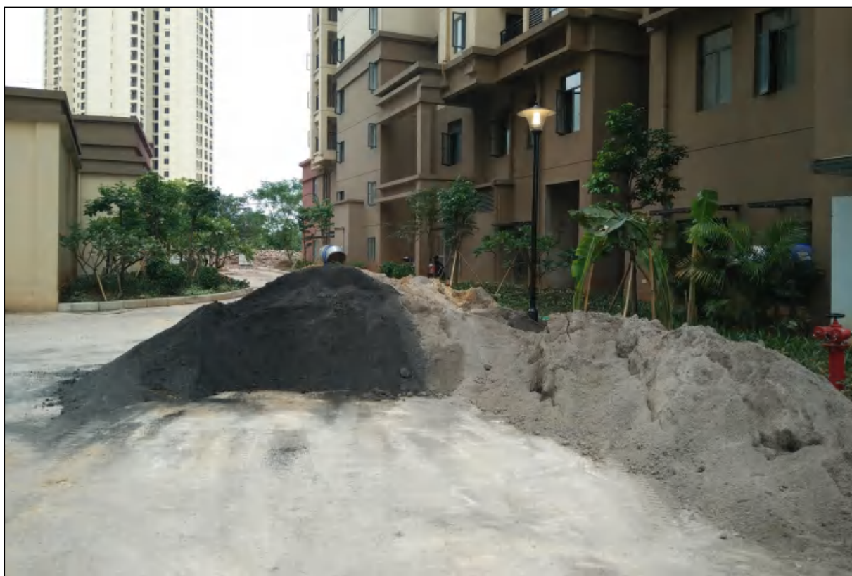
项目用地西地块用地内堆料场现状，建议遇降雨及时做好临时覆盖措施
