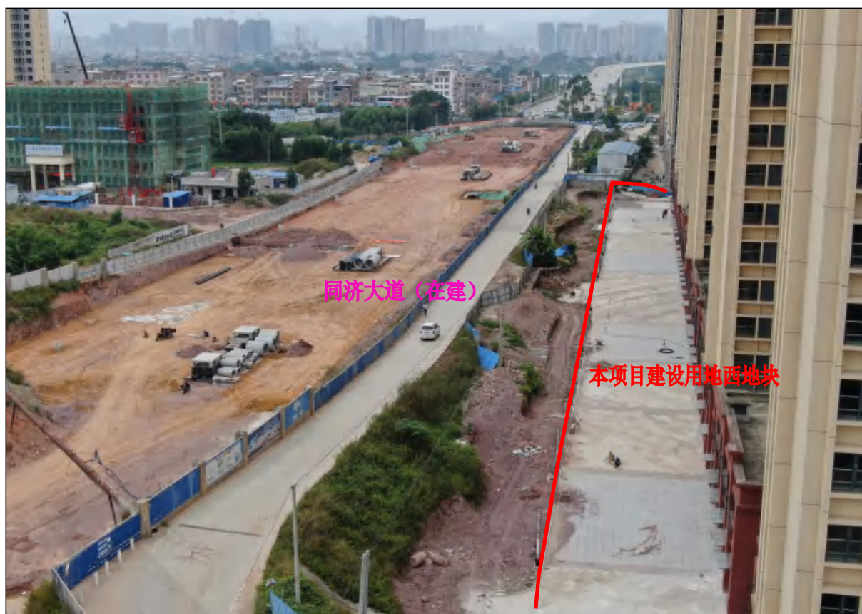
项目用地西地块西西面紧邻在建同济大道用地现状，地面已完成硬化铺装工作
