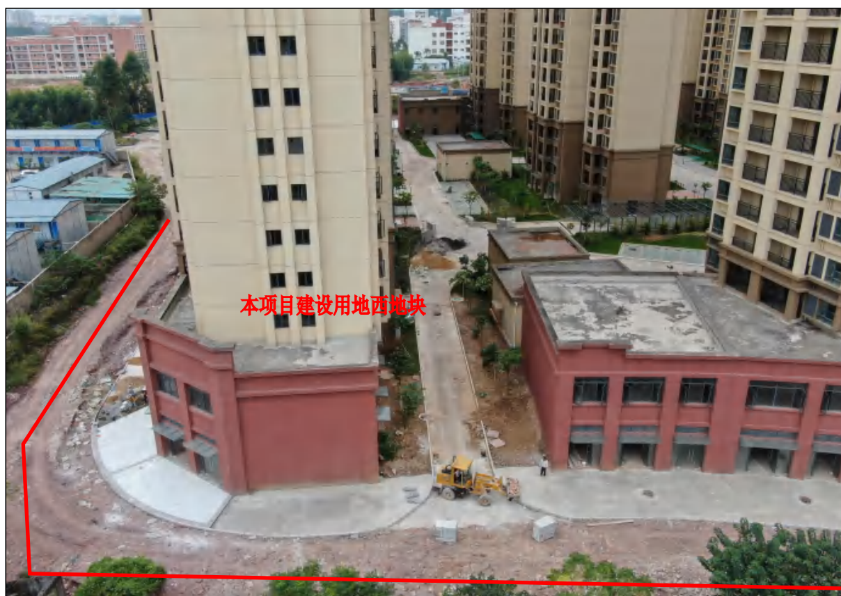
项目用地西地块东南面现状，现状进行铺砖、排水、绿化等附属设施建设
