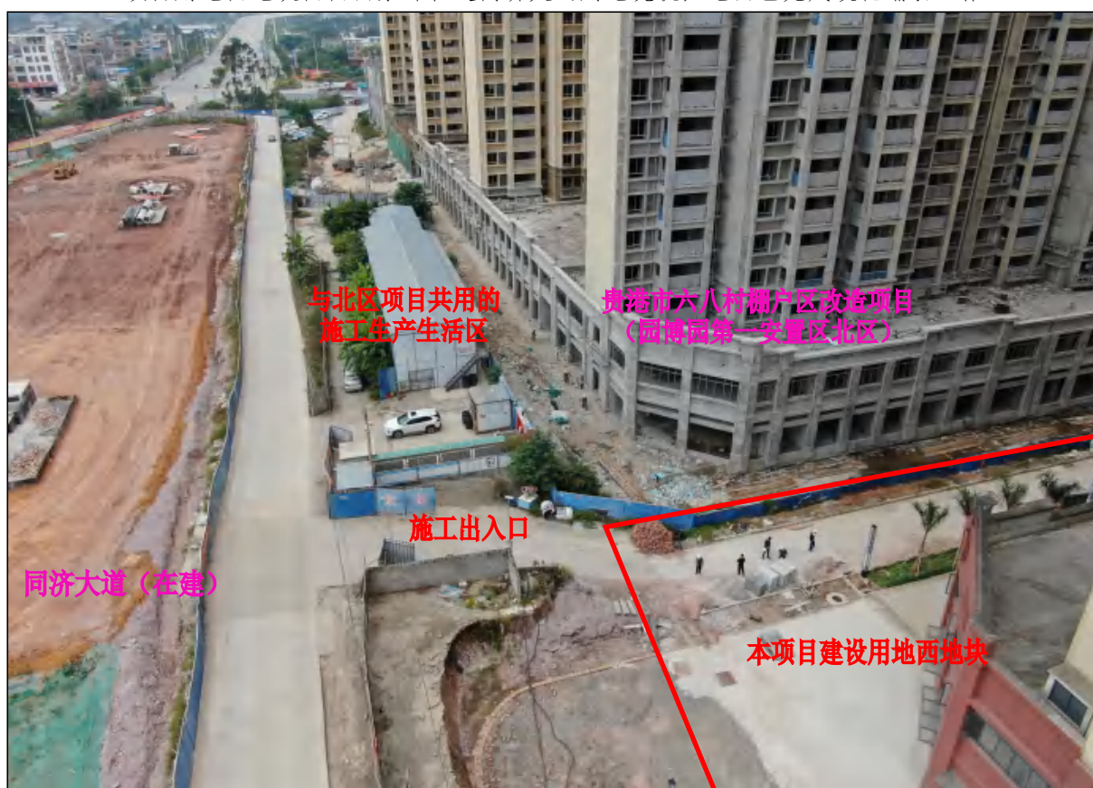
项目用地西地块西北角与北区项目共用施工生产生活区现状，项目施工出入口现状
