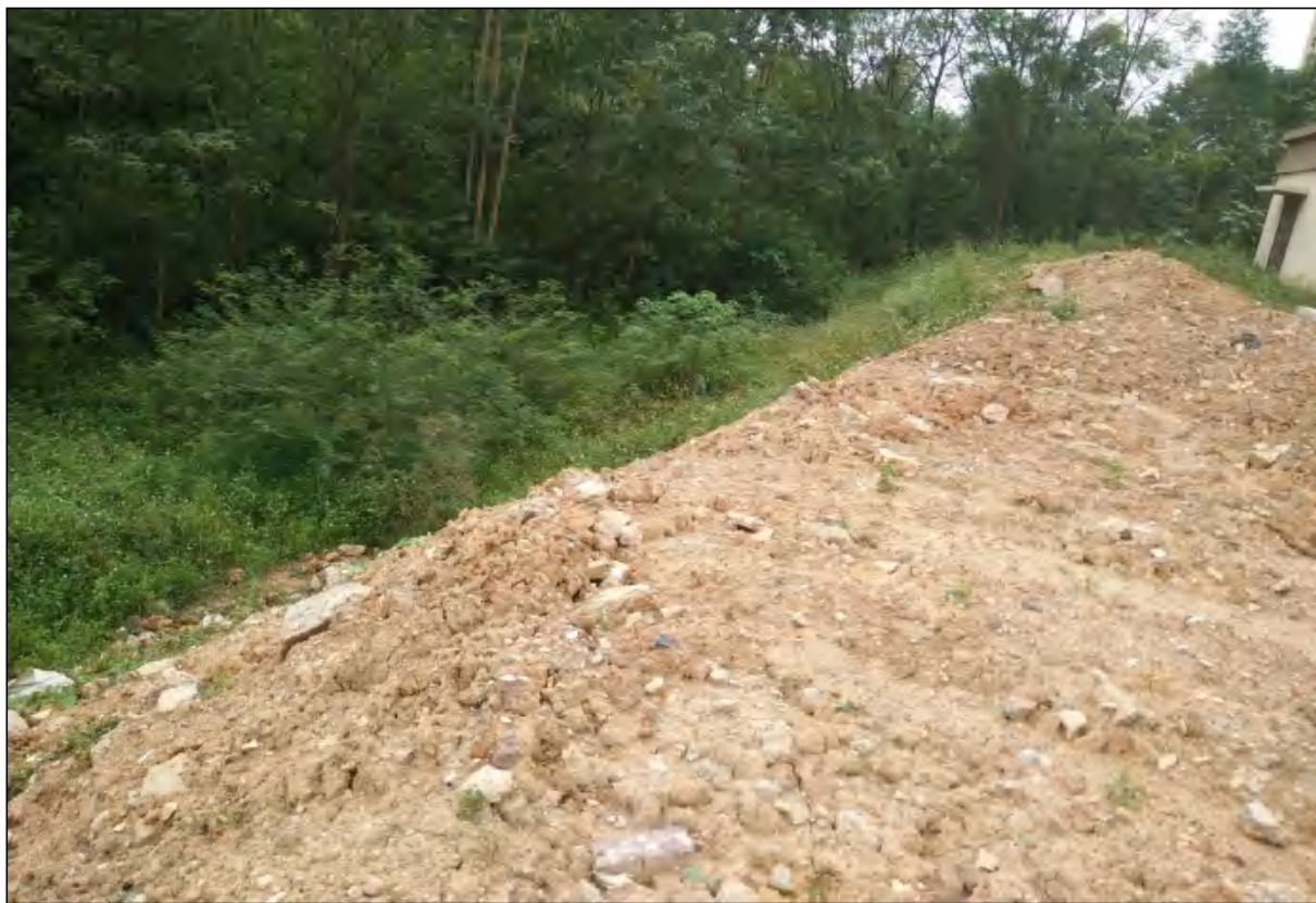
项目用地东地块东南面临时边坡现状，建议坡面临时覆盖密目网，减少水土流失
