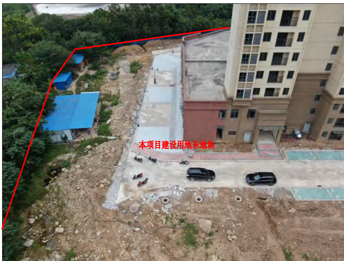
项目用地东地块东北面现状，现状进行绿化、道路、硬化铺装等附属设施建设
