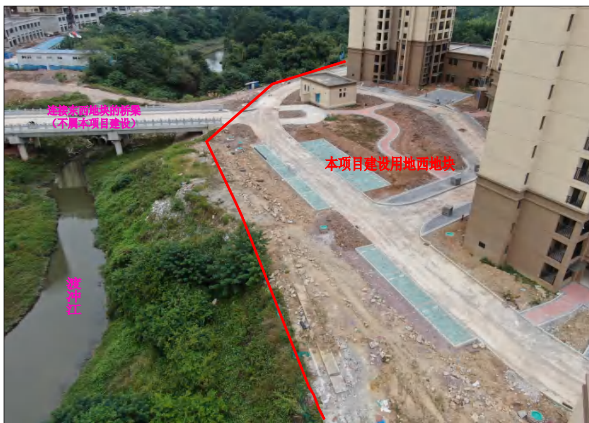
项目用地东地块西北面现状，现状进行绿化、道路、硬化铺装等附属设施建设
