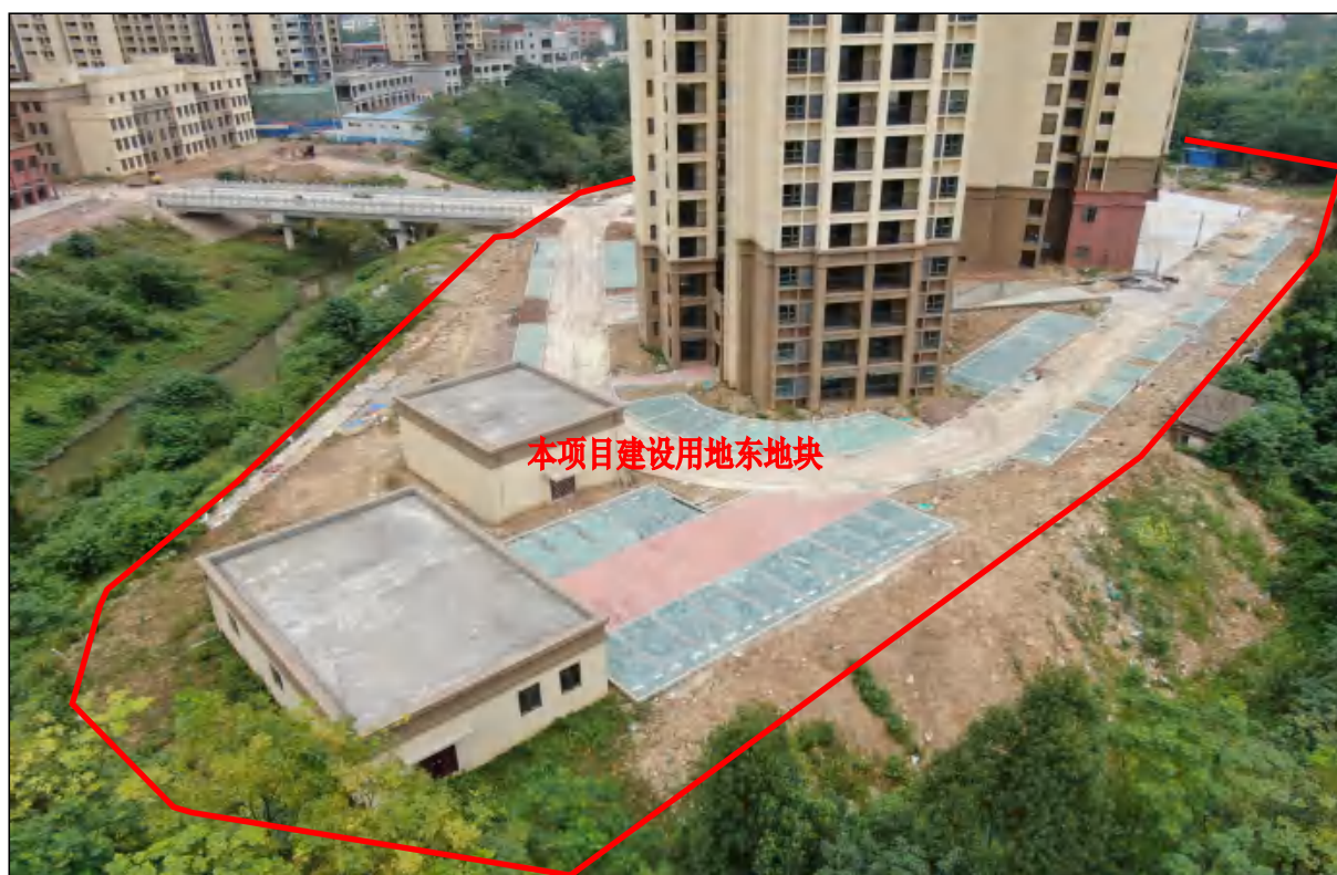
项目用地东地块南面现状，现状进行绿化、道路、硬化铺装等附属设施建设
