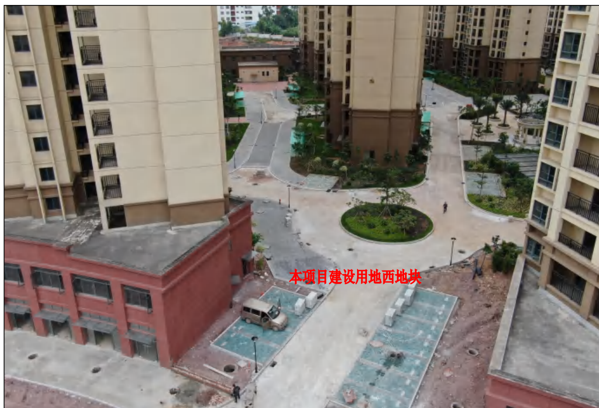
项目用地西地块中部现状，现状已完成绿化种植，正在进行小区内道路硬化及铺砖工作
