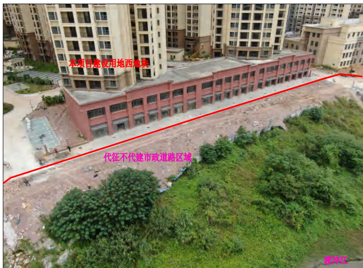
项目用地西地块东面用地现状，现状正在进行硬化铺装工作
